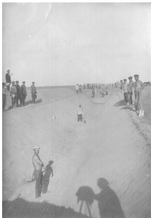
1927 год. Строительство Терских каналов. Сухопадинский канал. Прораб-студент ДПИ И.К. Федичкин
