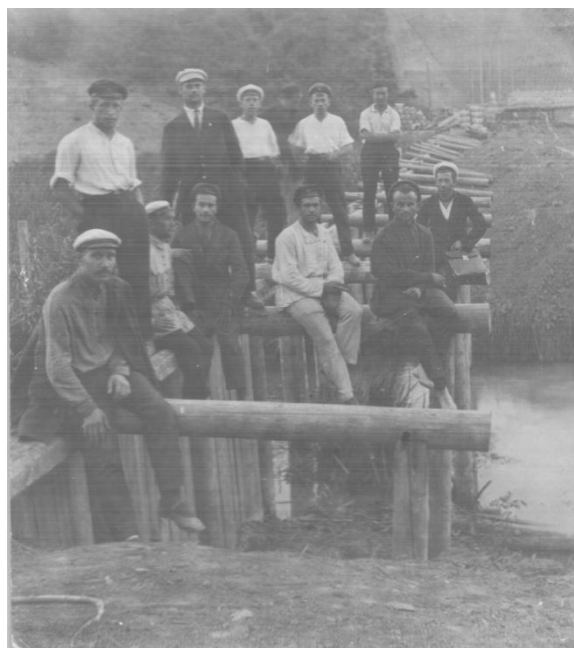
Студенты инженерно-мелиоративного факультета ДПИ на строительстве Терских каналов в 1927 г. М.М. Скиба, И.К. Федичкин, И.М. Кочеров, Г.И. Лапшин др.
